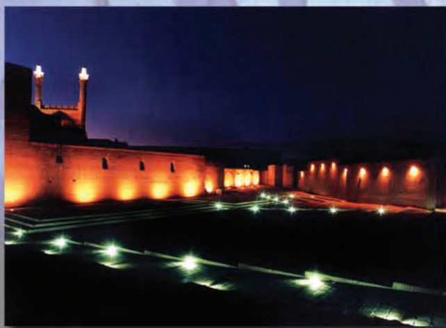
مشاوره، طراحی و اجرای پروژه نورپردازی مجموعه سرای ملل - ۱۳۸۳
